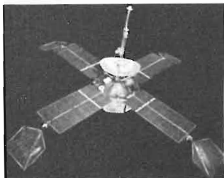
Fig. 1 - La sonda per Marte Mariner IV con le quattro grandi pale portanti le cellule solari e le « vele » fissate per misurare la pressione della luce.
